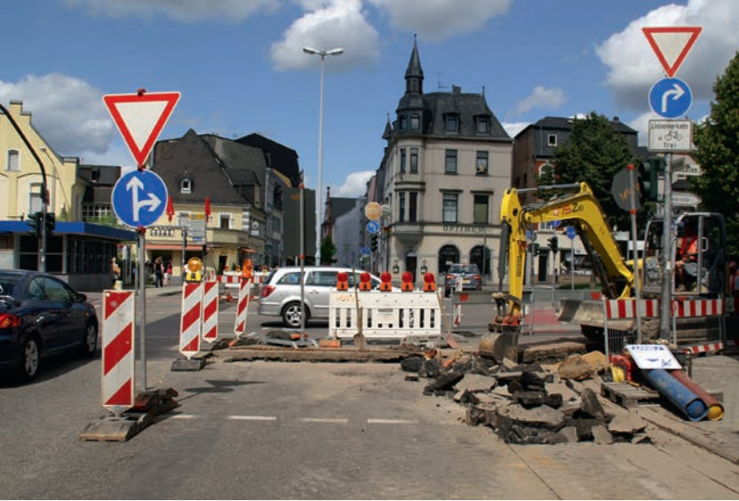
Baustellen der Stadtwerke zeigt das GIS der SWT als temporäre Sperrflächen an.
