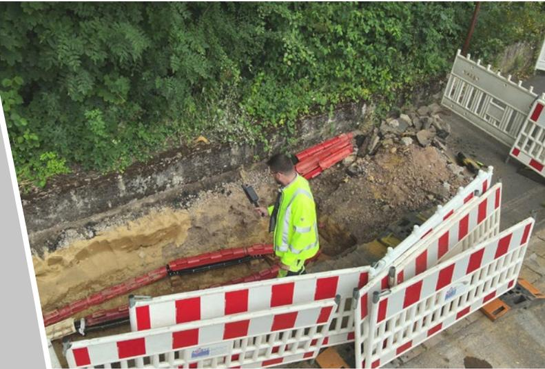
Um den Daten-Pool für das 3D-Modell von Saarlouis zu „füllen“, dokumentieren die SW SLS alle Tiefbauarbeiten, via Handy-Scan auf Basis von Laser-Technologie (LiDAR).
