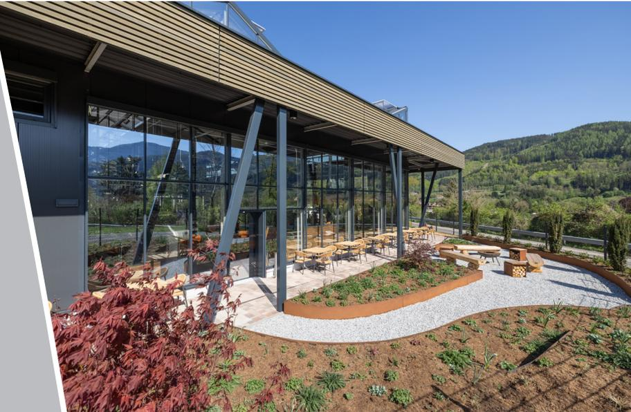
Schön, tragfähig und funktionell: Das Dach des Gartencenters wird über die Stahlstützen entwässert.
