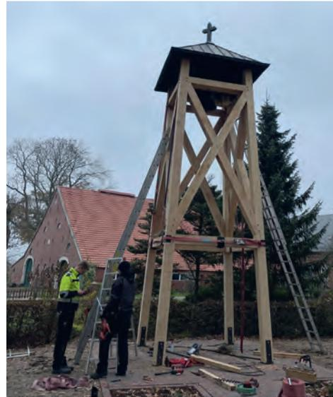
Sanierung des Glockenturms auf dem Dach der Marienheider Wallfahrtskirche. Balken und Bretter wurden auf dem Gelände von Haveloh genau vermessen und digitalisiert. So entstand ein exaktes Modell des historischen Bauwerks für einen originalgetreuen Nachbau.
