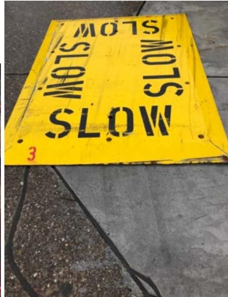
Die Stahlplatte als erste provisorische Abdeckung eines Schadens.
