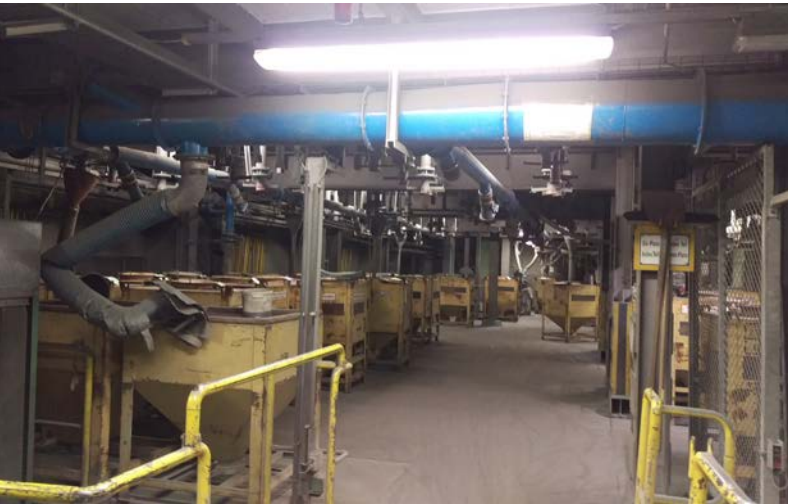
Typisch Altbau: Rohre und Rohrknotten, an die man kaum herankommt; aktuelle, vollständige Pläne fehlen.
