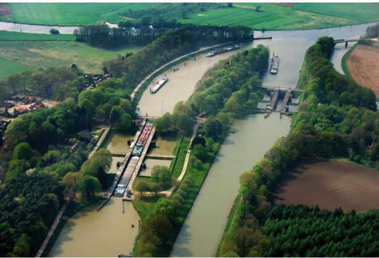
Die Elektroplanung für den Schleusenneubau Gleesen verlief reibungslos.
