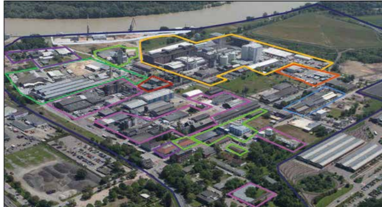
Die Instandhaltungsabteilung der BK Giulini GmbH verwaltet auch die Dokumentationen vieler im Industriepark Ludwigshafen ansässiger Firmen.
