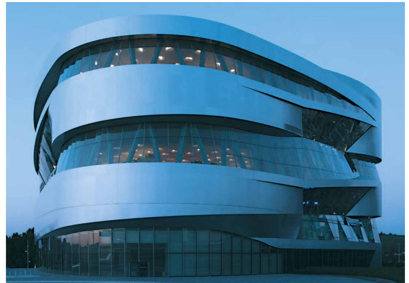
Beim Mercedes-Benz-Museum in Stuttgart wurde durch 3D-Planung die CAM-unterstützte Fertigung von speziell geformter Schalung möglich.
